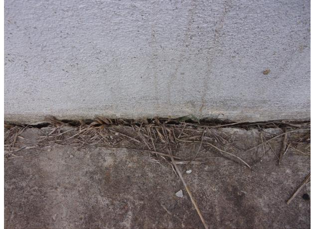
Dalle en béton non jointive autour de l'ouvrage abritant le forage B
