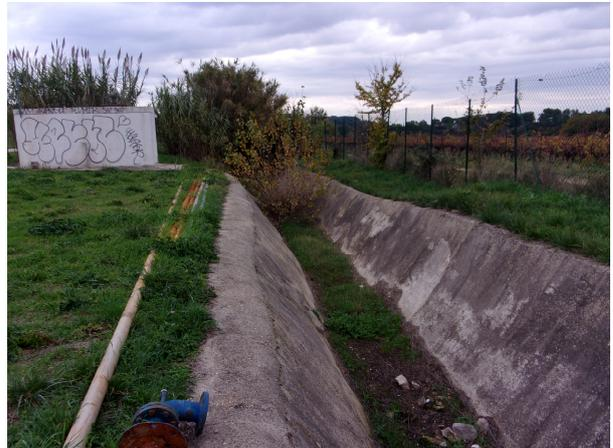
Caniveau bétonné en mauvais état
