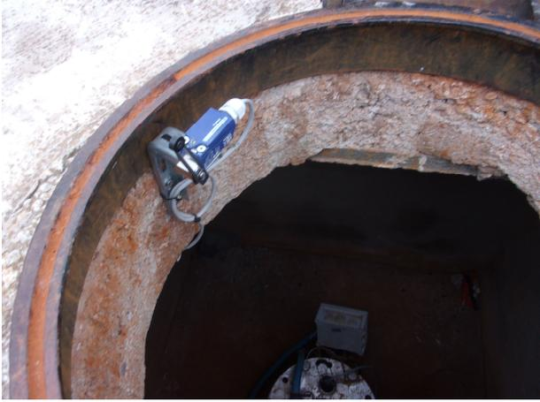
Dispositif anti intrusion sur l'ouvrage abritant le forage D
