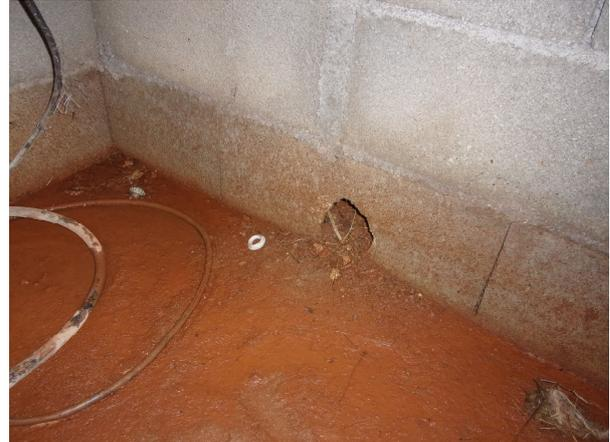
Trou à colmater à l'intérieur de l'ouvrage abritant le forage C
