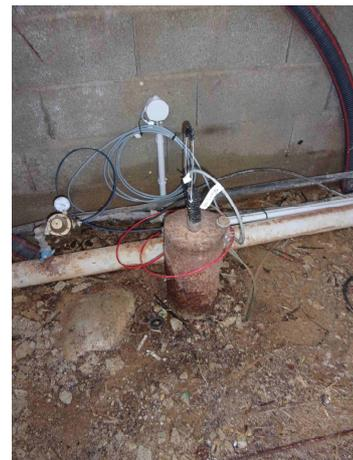
Local à nettoyer avec mise en place d'une dalle étanche autour du piézomètre A
