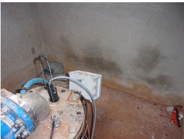
Tube au niveau de la tête de forage D permettant de mesurer le niveau dynamique.
