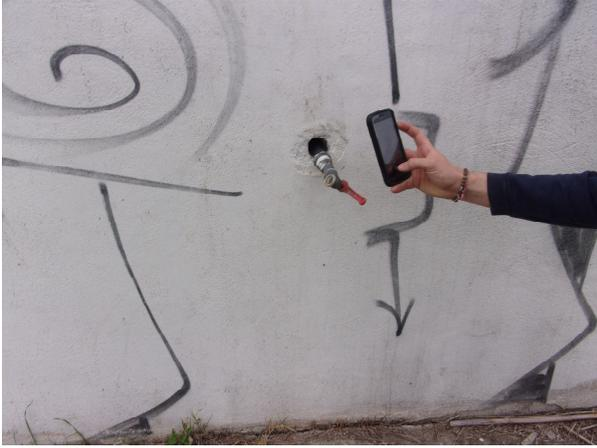
Robinet permettant de réaliser des prélèvements
