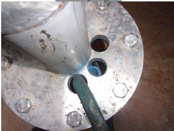
Tube au niveau de la tête de forage B permettant de mesurer le niveau dynamique.
