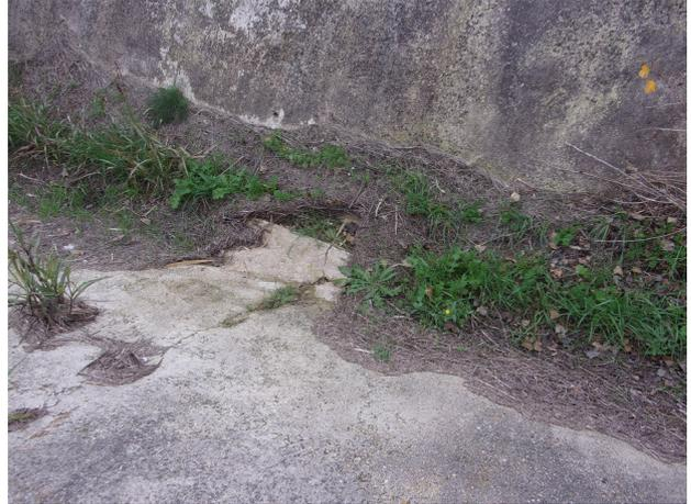
Dalle en béton en mauvais état autour de l'ouvrage abritant le forage D
