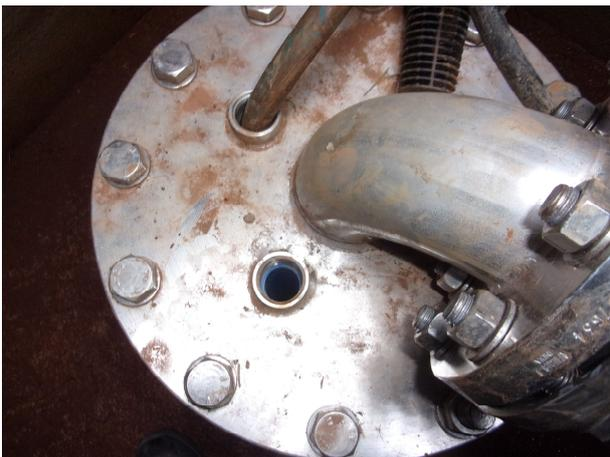
Tube au niveau de la tête de forage C permettant de mesurer le niveau dynamique.
