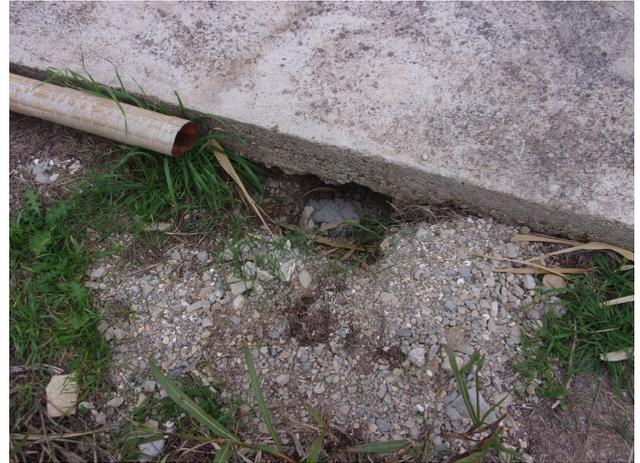
Ouverture sous la dalle de l'ouvrage abritant le forage D
