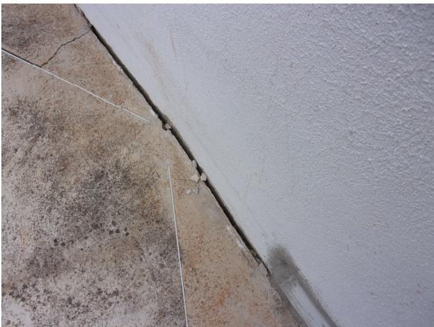
Absence de jointure entre la dalle autour du forage B et le bâti abritant cet ouvrage
