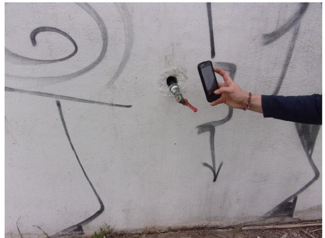
Ouverture à colmater au niveau du robinet du captage du forage B
