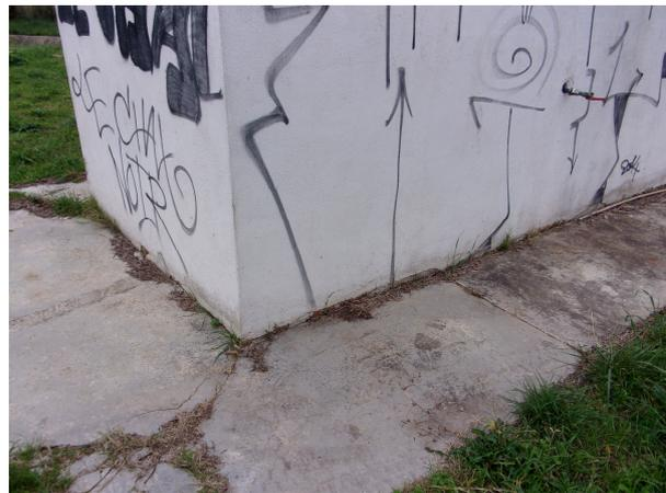
Dalle béton dégradé autour de l'ouvrage abritant le forage B
