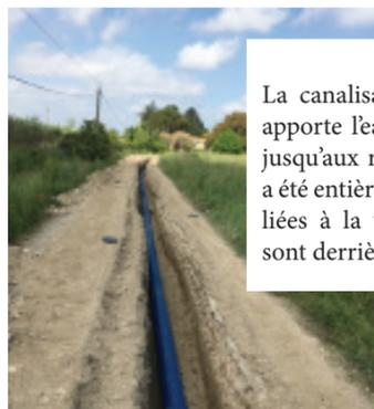
La canalisation de refoulement, qui apporte l'eau des forages du Liverna jusqu'aux réservoirs de la commune, a été entièrement renouvelée. Les pannes liées à la vétusté de la canalisation sont derrière nous.
