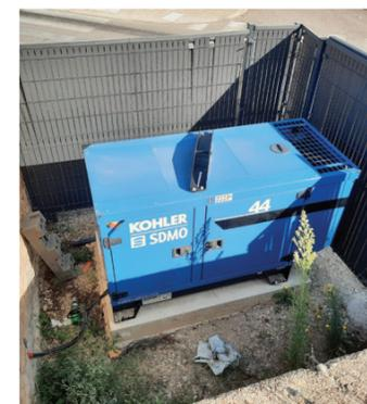
Les réservoirs ont été dotés d'un groupe électrogène pour assurer la continuité de la distribution d'eau en cas de panne électrique.
