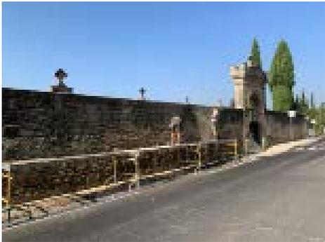
Au vu du délabrement de la façade principale du cimetière, avec risque d'effondrement de certains blocs de pierre, la nouvelle municipalité a décidé de procéder à des travaux de rénovation. L'objectif est de nettoyer et consolider l'ensemble de l'édifice qui fait partie de notre patrimoine collectif.
